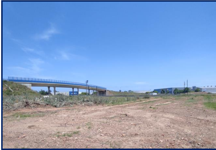
Imagen 5: Vista hacia el puente de acceso al polígono industrial desde la zona sur de la zona de actuación
