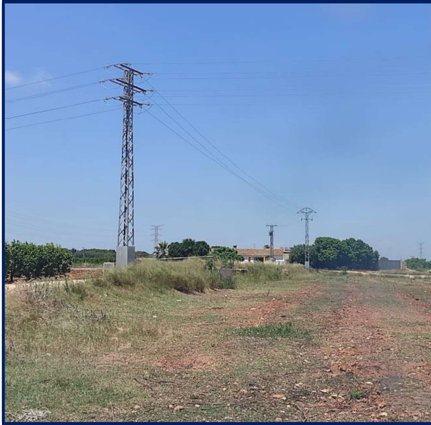
Imagen 8: Línea eléctrica existente donde se realizará el punto de conexión a red
