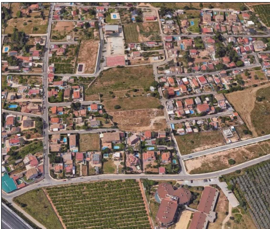
FOTOGRAFÍA AÉREA DEL ÁMBITO DE LA ACTUACIÓN.
